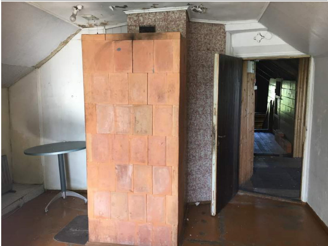
F 13. Katusealuse ruum üsna uue lihtpottidest ahjuga. Põrandaid katab papp. Ruum nr 12 (Lisa 3).
