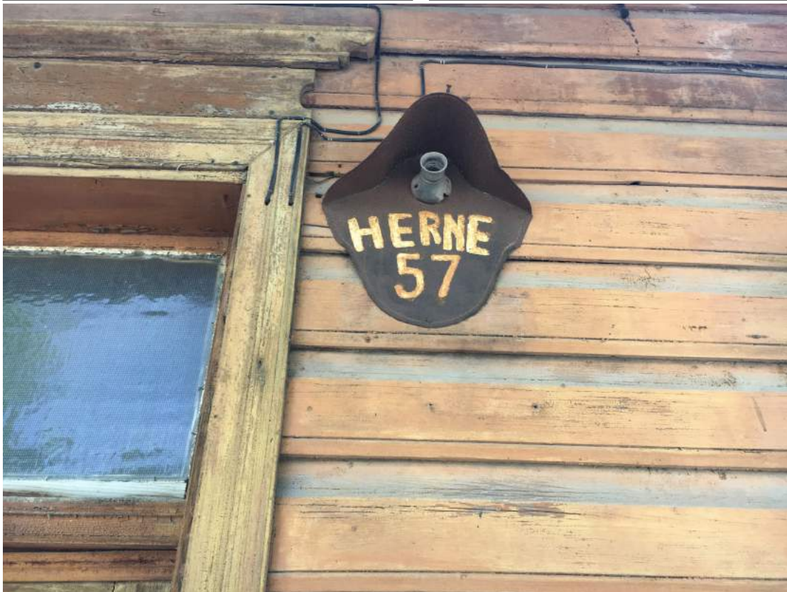
F 7. Tiibukse kõrval olev metallist majanumbrinäit. Tiibuksel on säilinud dekoratiivsed piirdeliistud ja ukse lähedal on säilinud algupärane Tartu profiiliga laudis.
