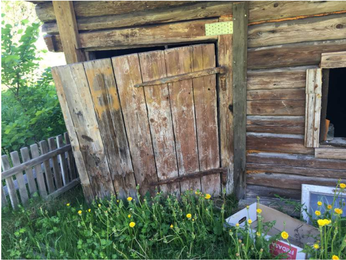
F 10. Vana lauda uksel on säilinud kaks metallist latthinge.
