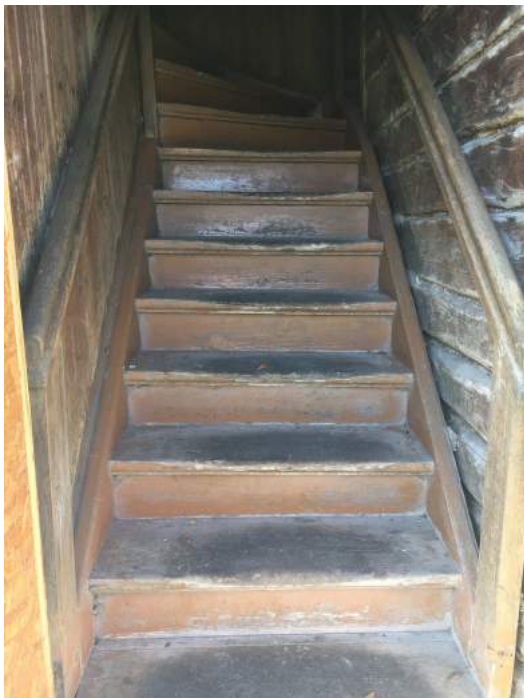
F 16. Trepi alumine osa. Paremäl näha viimistluseta palksein.
