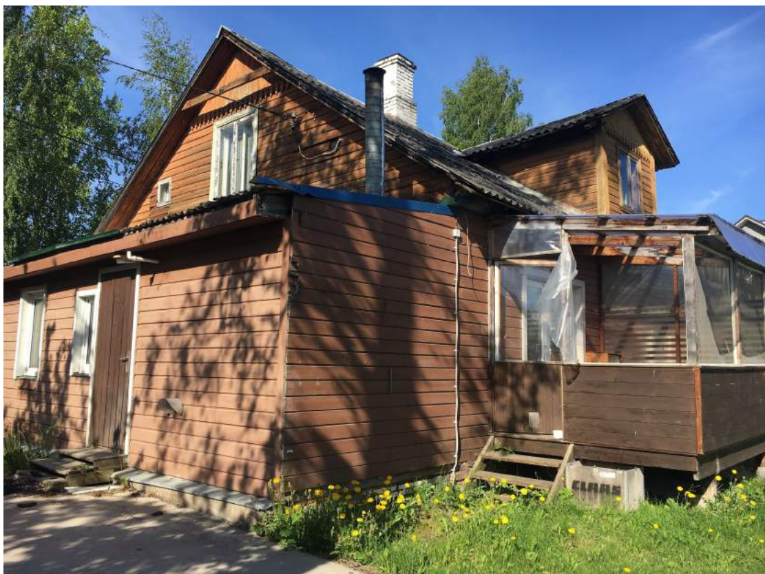
F 4. Vaade hoonele kagust. Vasakul trepikoja juurdeehitus ja paremal verandalaadne pooleliolev juurdeehitus.
