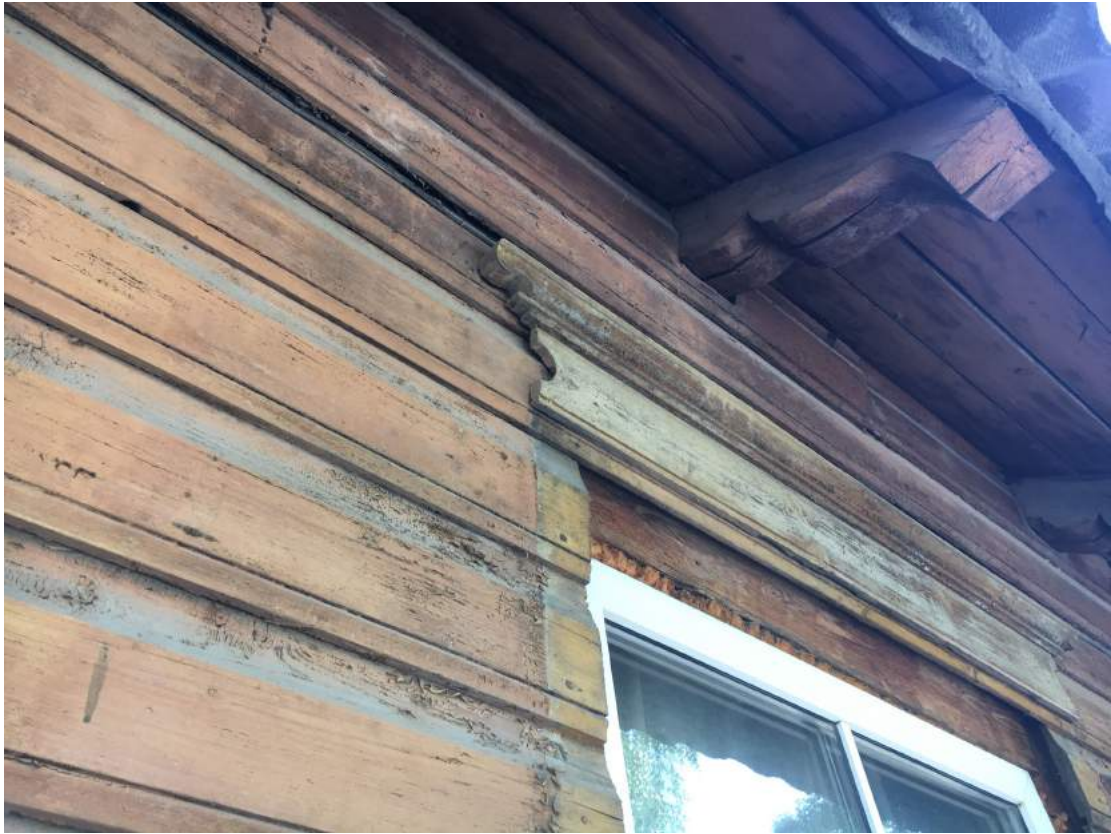
F 8. Osaliselt säilinud akende dekoratiivsed piirdeliistud Herne tn poolsel fassaadil. Näha on profileeritud sarikaotsad.
